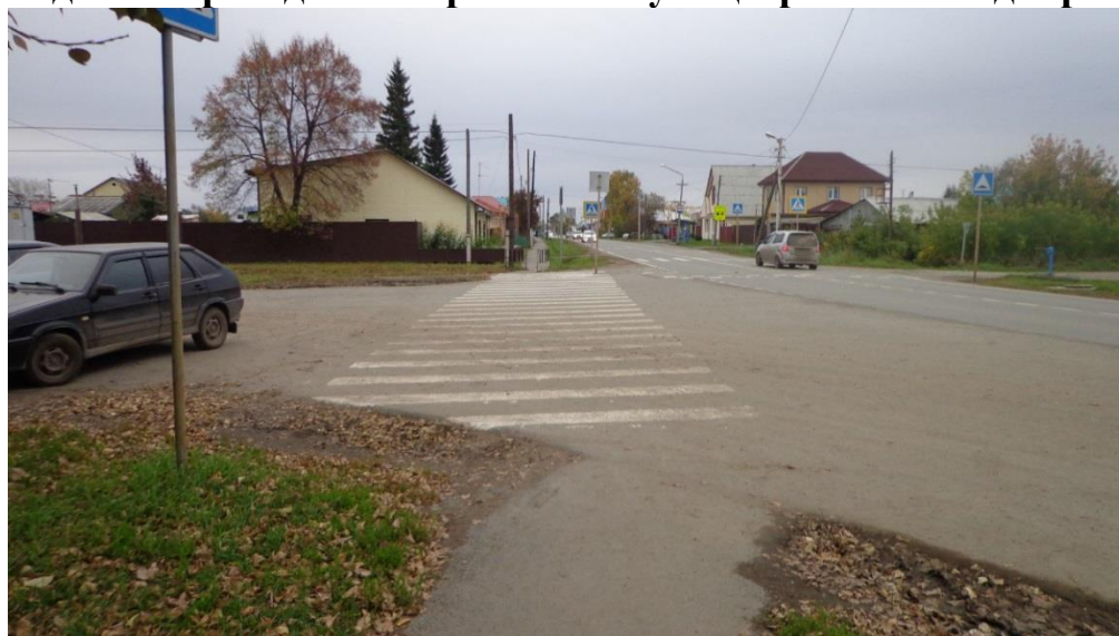
Пешеходный переход по улице Ершова
