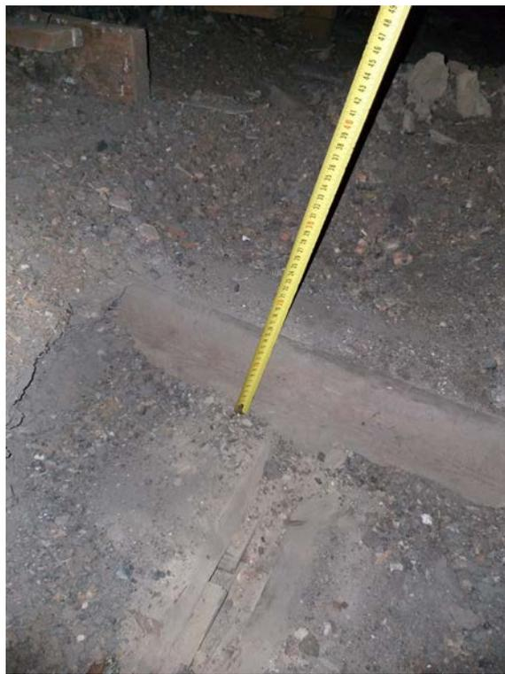
**Фото 92. Вскрытие чердачного перекрытия в осях 1-6; А-В**
