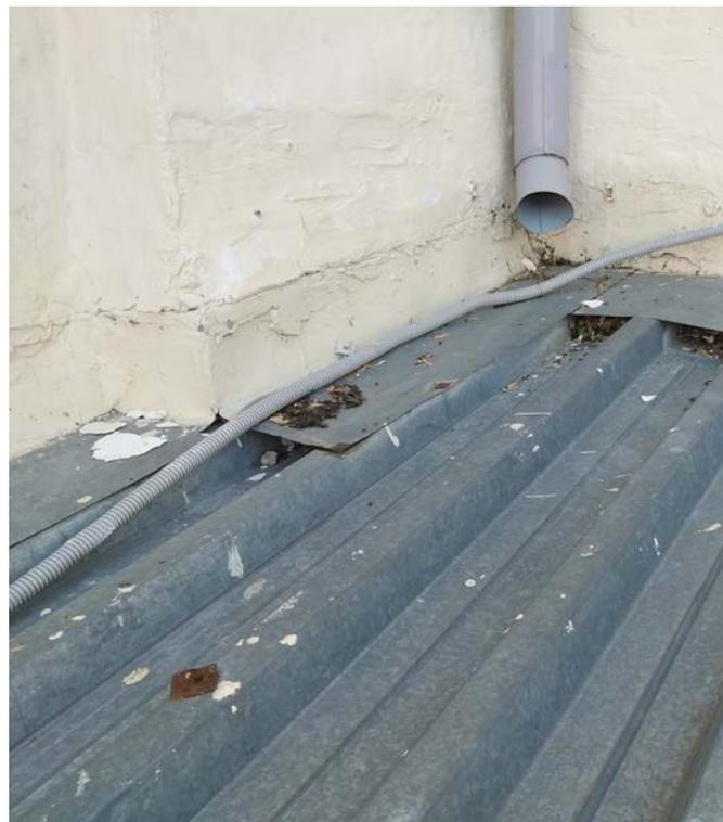
**Фото 20. Примыкание кровли над актовым залом к выступающим частям**
