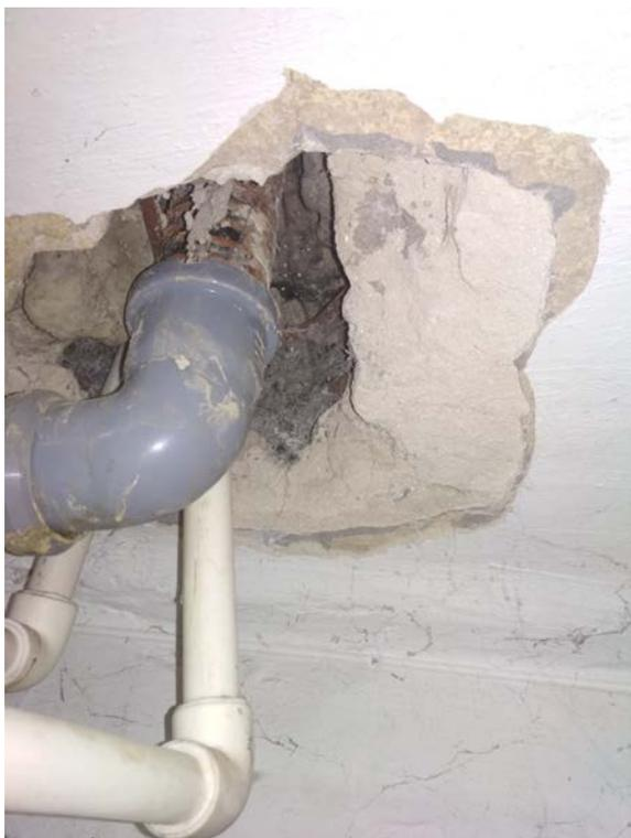
**Фото 82. Прохождение инженерных сетей через монолитное железобетонное перекрытие**
