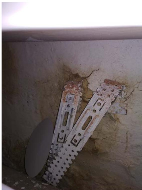
**Фото 64. Металлический каркас обшивки**
