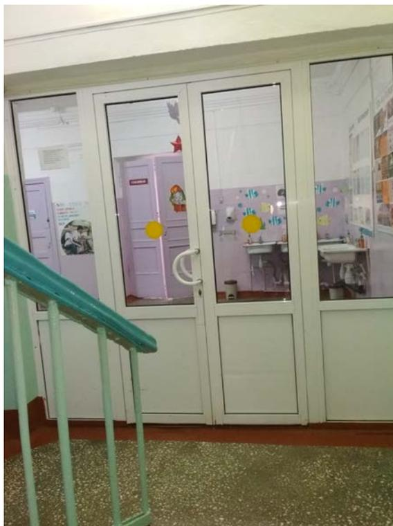
**Фото 38. Общий вид алюминиевой перегородки между лестничной клеткой и коридора в трехэтажной части здания**
