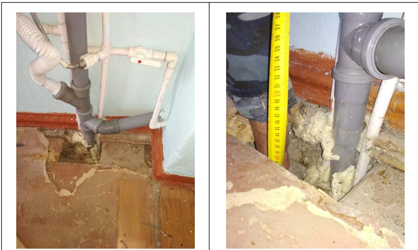
**Фото 95. Вскрытие пола по монолитному железобетонному перекрытию в осях 1-6; А-В**
