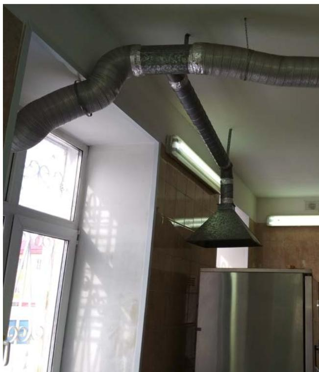
**Фото 55. Механическая вентиляция в пищеблоке**
