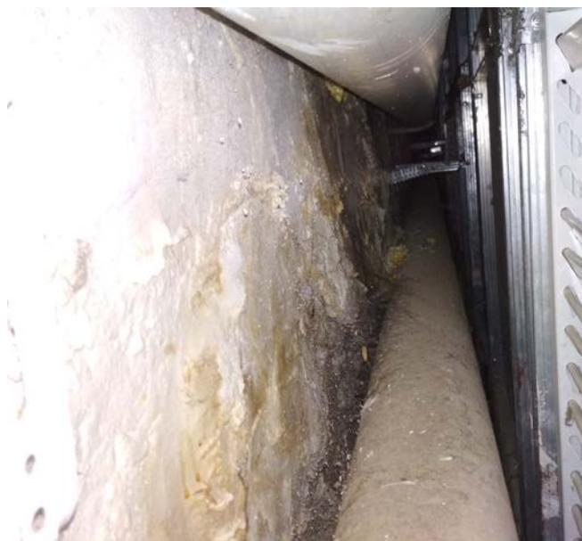
**Фото 63. Обшивка стен актового зала листами ГКЛ на металлическом каркасе**
