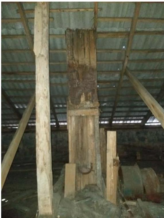
**Фото 29. Общий вид вентиляционной шахты, обшитой досками**
