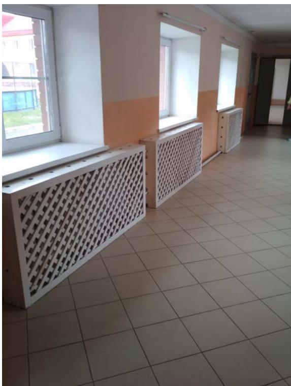
**Фото 59. Ограждение приборов отопления деревянными решетками**
