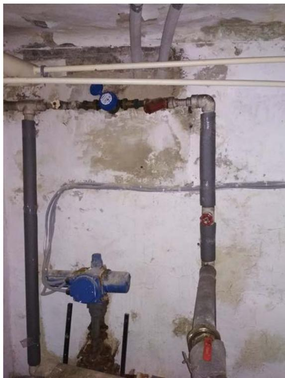
**Фото 81. Тепловой узел в подвале в осях 1-6; А-В**
